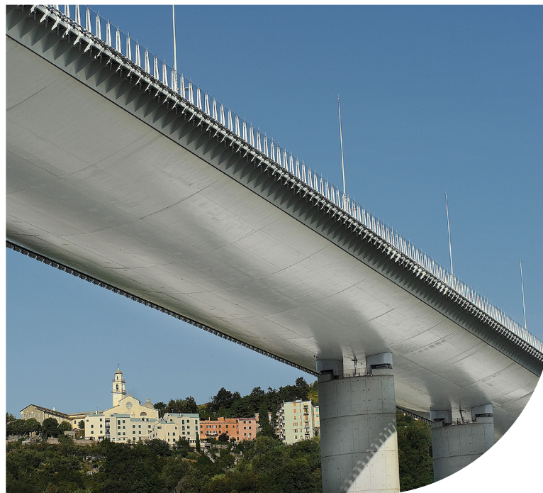
Voor de wederopbouw van de brug van Genua in Italië gebruikte Heidelberg Materials cement met ongeveer 40% gerecycleerd materiaal en een aanzienlijk lagere CO 2 -voetafdruk.
