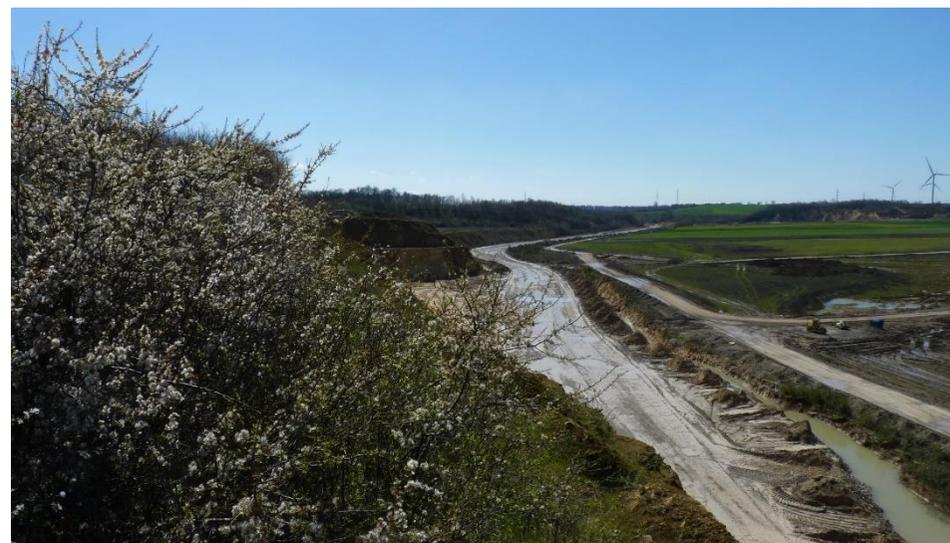
**Figure 9 : Circulation en carrière : piste des 100 tonnes à gauche, et piste poids-lourds clients et autres à droite**
