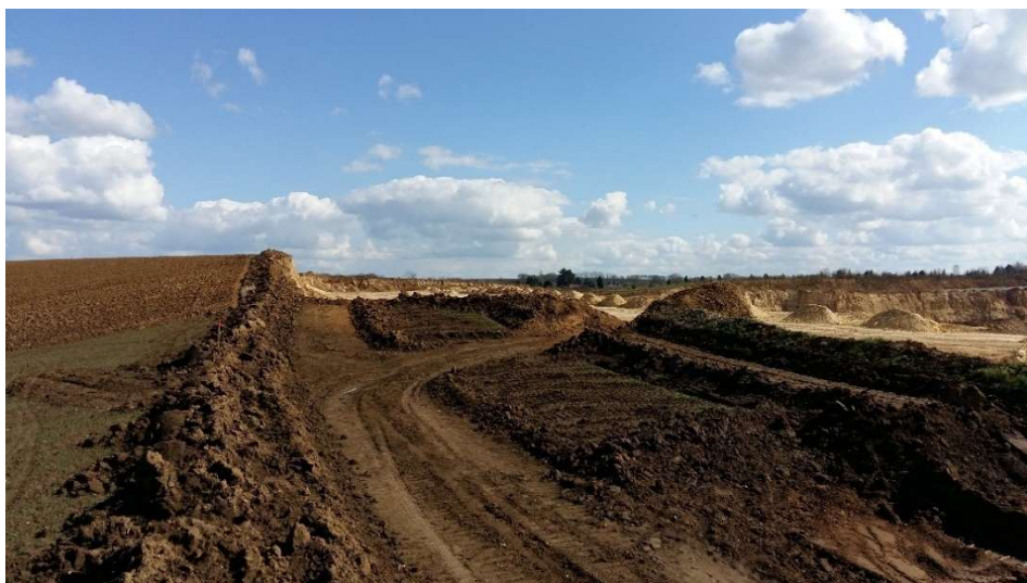
Figuur 5 : Uitgravingswerken vóór de fronten
