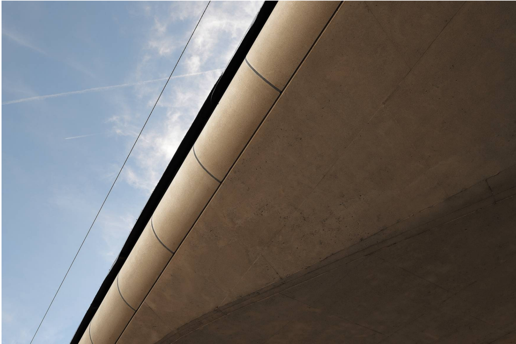
Leuven, Martelarenlaan - brug
