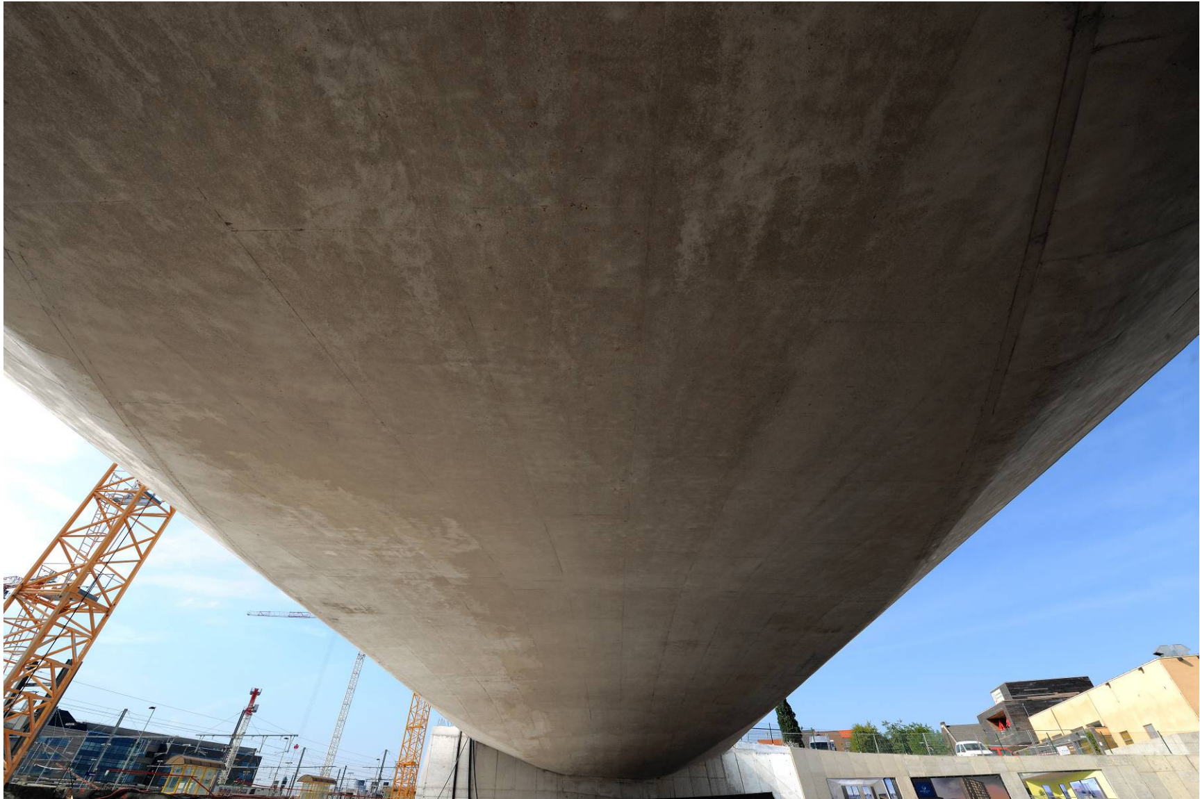
Leuven, Martelarenlaan - brug
